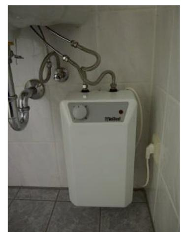
Schaltbare Steckdosen ermöglichen einen Warmwasserbetrieb von Untertischgeräten zu vorgegebenen Zeiten
